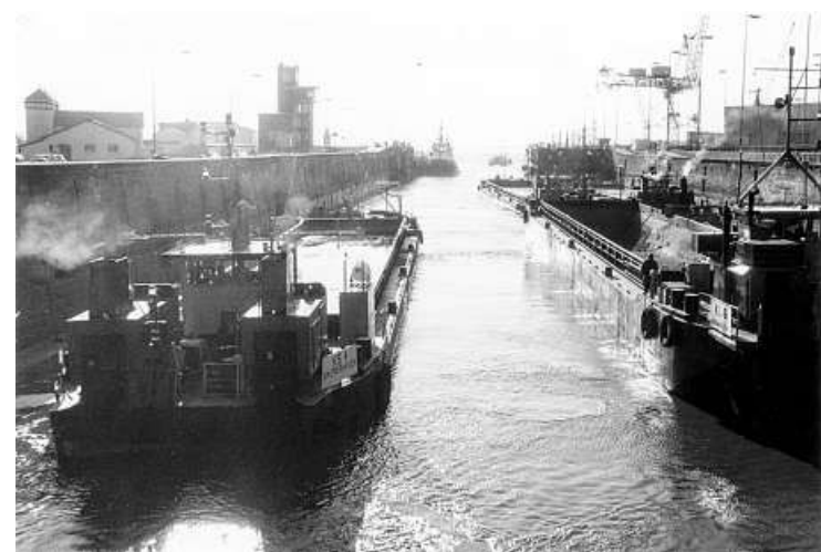
Foto von 1994: Aufgrund von Sturmflut und darauf folgender Ebbe konnte die Kaiserschleuse zeitweilig nicht mehr arbeiten.
