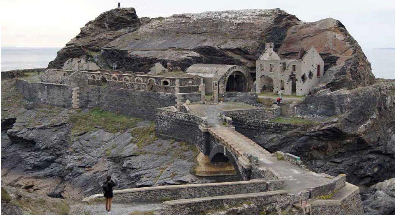
Im Felsen gut getarnter Teil des Atlantikwalls: Fort des Capucins bei Brest Foto: Sylvie Ungauer
