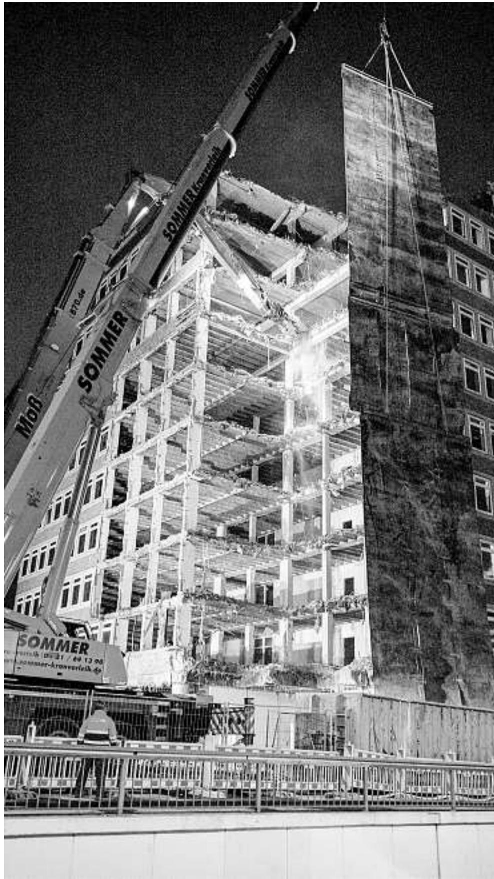
Beim Abbruch des Kühne + Nagel-Gebäudes geht es voran. Im Mai soll es dem Erdboden gleich gemacht sein. FOTOS: CHRISTINA KUHAUPT
