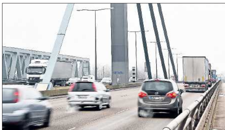
Über die in die Jahre gekommene Rheinbrücke zwischen Wörth und Karlsruhe rollen täglich 80.000 Fahrzeuge.
