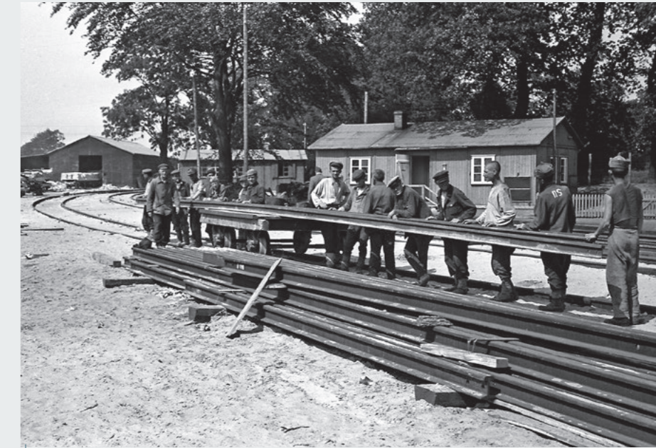
Sowjetische Kriegsgefangene beim Transport von Stahlträgern auf der Baustelle des Bunkers Valentin Foto: Johann Seubert, © Landeszentrale für politische Bildung Bremen
