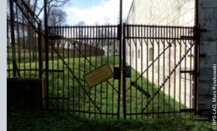
Der Zugang zum südlichen Flankengraben des Forts Oberer Kuhberg
