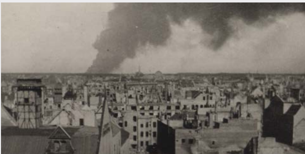
Schäden der Bombenangriffe in der Südstadt Hannovers (Quelle: HAZ)
