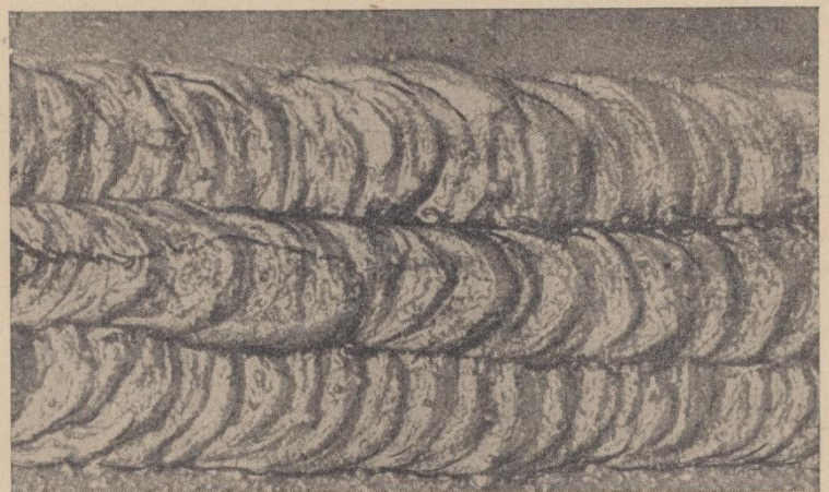
Bild 3 b. Durch das Magnetpulverprüfverfahren werden die feinen Risse deutlich sichtbar.
