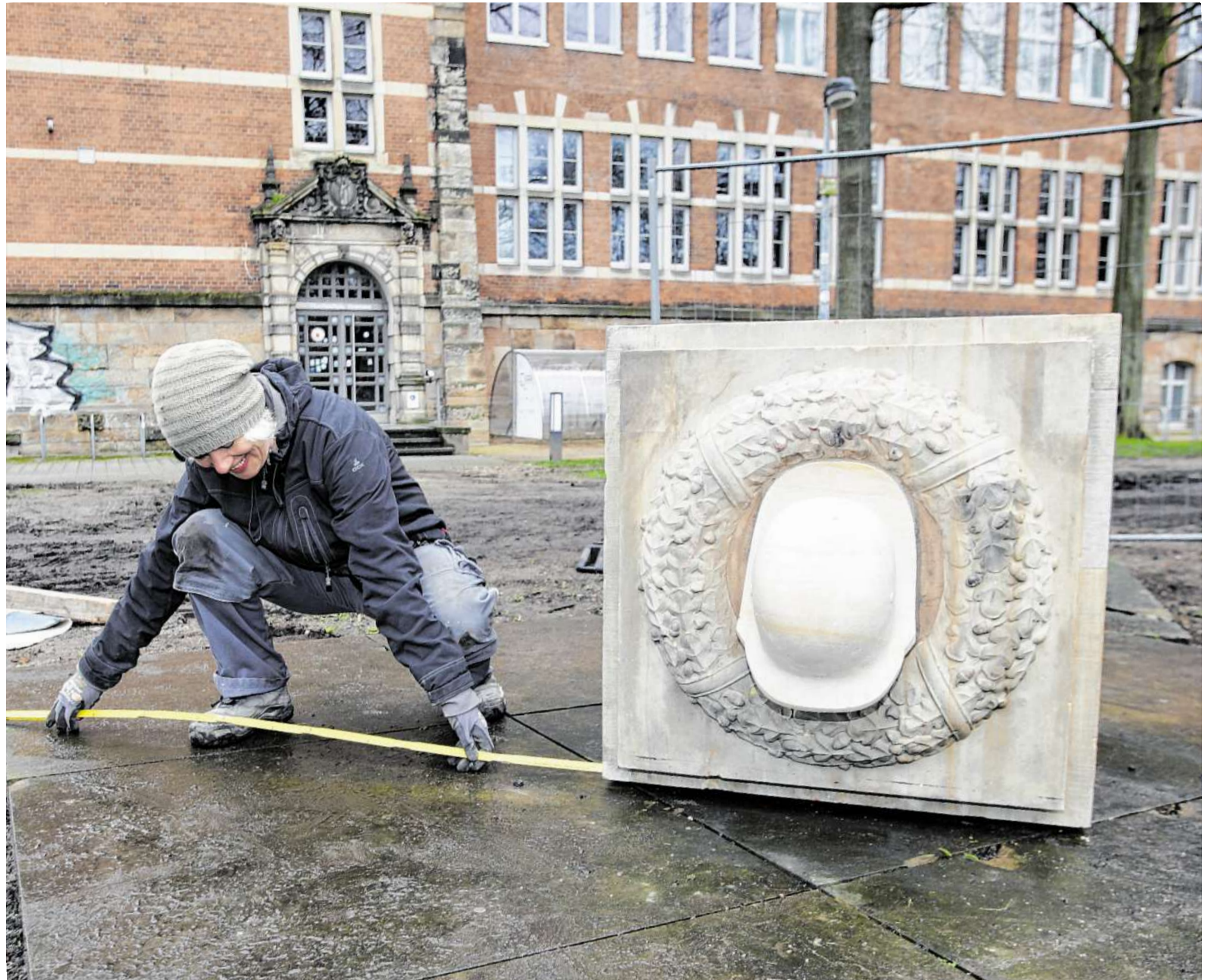
Passt genau: Bildhauerin Katja Stelljes hat das restaurierte Denkmal mittig auf der neuen Unterkonstruktion platziert. Mit dem Zollstock kontrolliert sie das Ergebnis.
