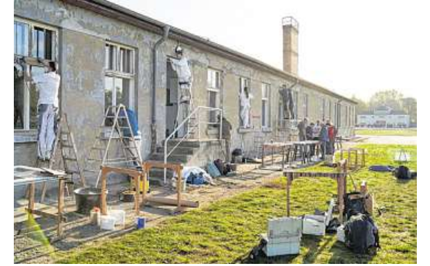
Die Baustelle an der alten KZ-Wäscherei und das Projekt „Lernen und Arbeiten“ des Schulzentrums Alwin-Lonke-Straße in Sachsenhausen.
