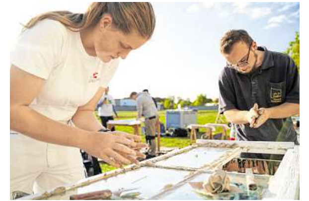
Teamarbeit beim Instandsetzen eines Originalfensters der ehemaligen KZ-Wäscherei.
