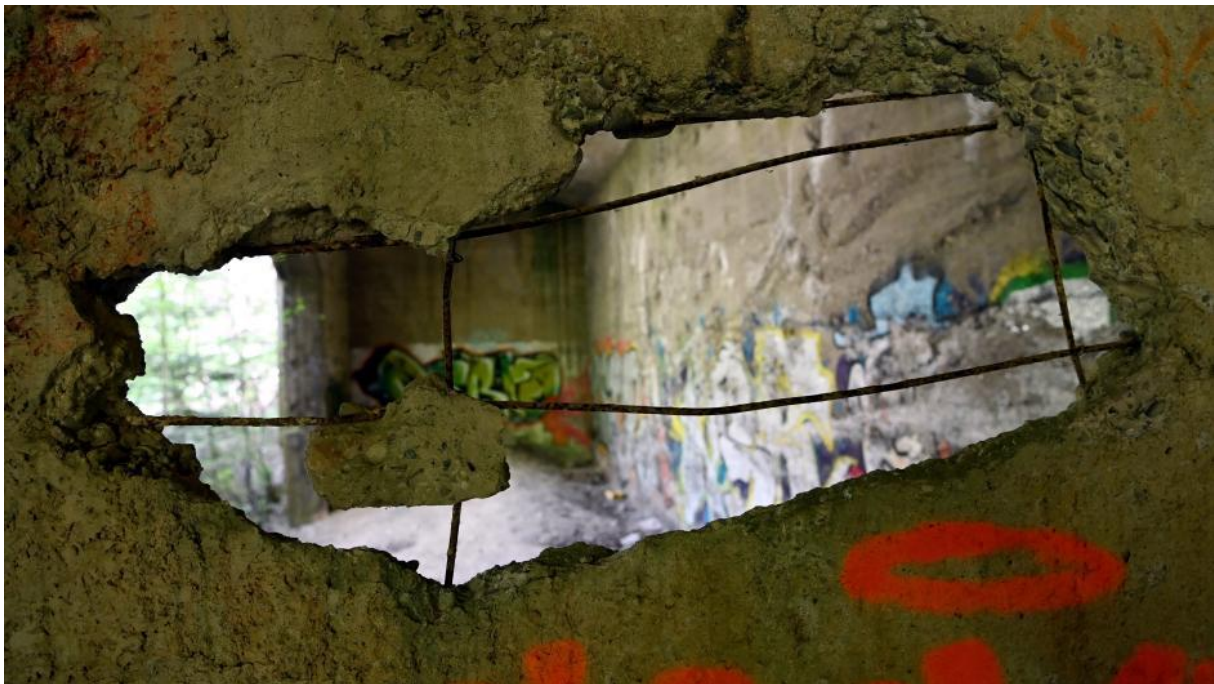
Die alten Militäranlagen sind heute denkmalgeschützt.
