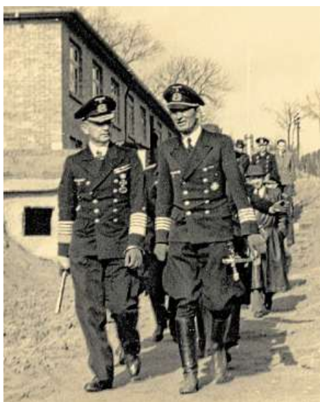
Im April 1944 besuchte Karl Dönitz die Bunkerbaustelle. Neben ihm: Marineoberbaurat Edo Meiners. FOTO: HEIMATVEREIN FARGE-REKUM
