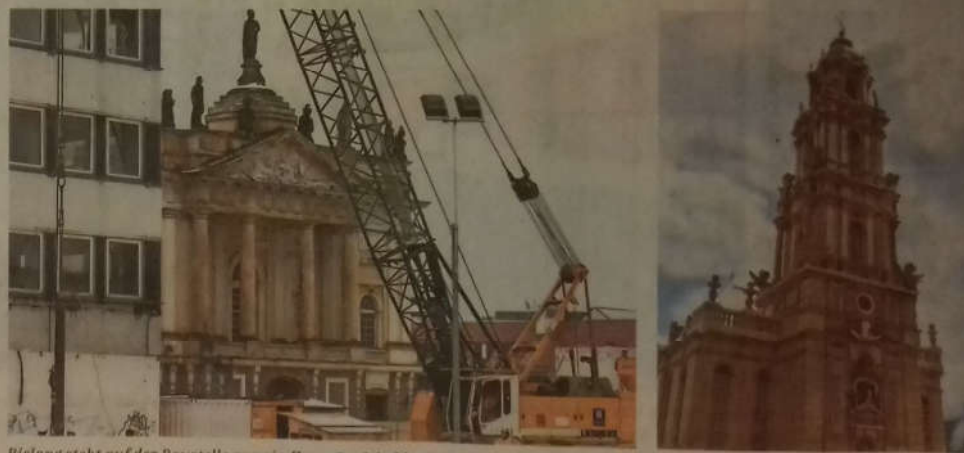
Bislang steht auf der Baustelle nur ein Kran. Doch bald soll Potsdams historisches Gesicht wieder vollständig sein. So wie auf dem Modell (rechts) soll die Garnisonkirche dereinst aussehen.
