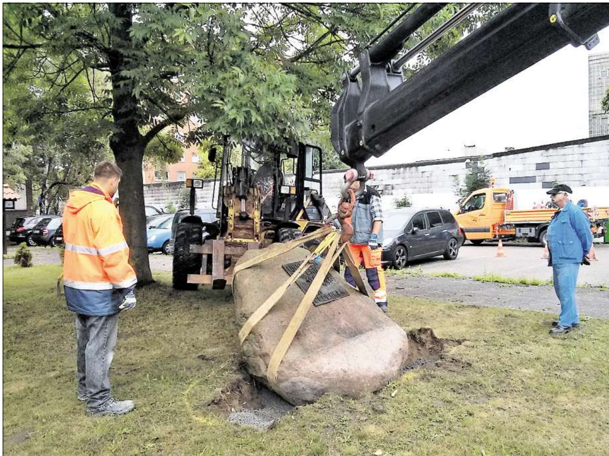
Seit 2013 wurde der Gedenkstein der SpVg Laatzen zweimal versetzt. Ein Autokran setzt den tonnenschweren Findling an prominenter Stelle vor dem Klubhaus ab. Winterheimer
