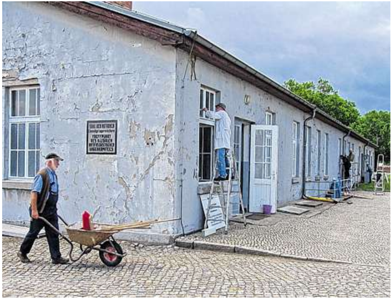
Ehemalige Berufsschullehrer wie Hans-Joachim Gries, der das Schulzentrum an der Alwin-Lonke-Straße in Burg-Grambke geleitet hat, nutzen ihre Kenntnisse für den Erhalt der Gedenkstätte Sachsenhausen in Oranienburg bei Berlin. Am Gebäude der ehemaligen Häftlingswäscherei streichen sie Fenster und Türen. FOTO: FR
