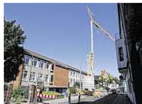
An der Grundschule Admiralstraße haben die Bauarbeiten für die neue Mensa begonnen. Weil der Innenhof von großen Fahrzeugen nicht erreicht werden kann, muss sämtliches Baumaterial per Kran von der Winterstraße aus über das Gebäude gehievt werden. AVE-FOTO: SCHEITZ
