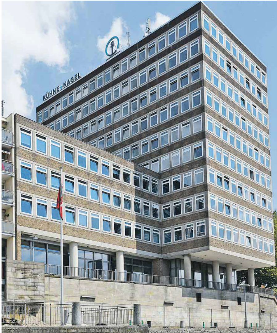
Umstrittener Ort: Oben will Kühne+Nagel neu bauen, unten in der Flutschutzmauer könnte das Mahnmal Platz finden Foto: Eckhard Stengel/imag
