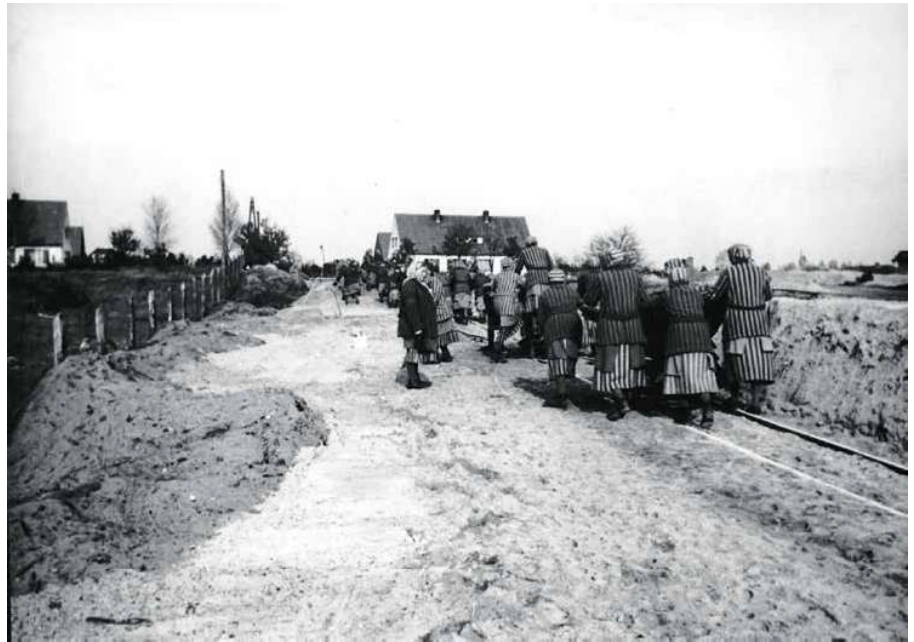
Häftlinge bei Arbeiten in den Anlagen der SS-Siedlung und beim Straßenbau Foto: Mahn- und Gedenkstätte Ravensbrück
