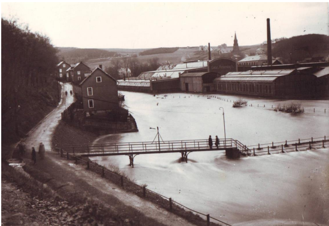
Abbildung 89 Fußgängerbrücke über die Ferndorf („Damaskusbrücke“) in Weidenau bei Hochwasser
