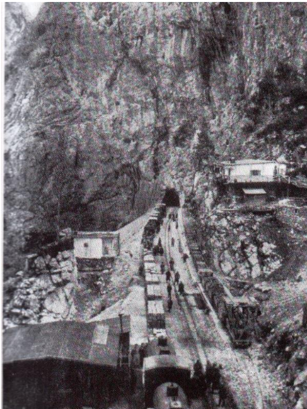
Abbildung 83 Bahnarbeiten an der Taurusstrecke
