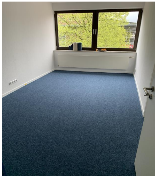
Mängel wurden schnell behoben und ein neuer Teppich in den Büroräumen verlegt (Foto: Tessa Hesener).
