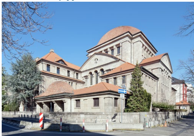
Frankfurt am Main-Westendsynagoge von Südwesten
